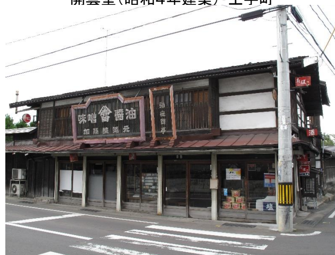
加藤味噌醬油醸造元(明治4年建築)・新寺町
