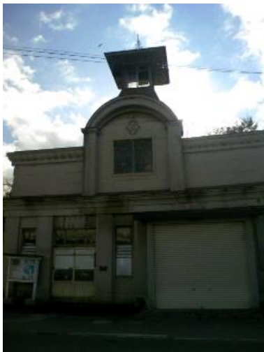
補修工事前の旧状
