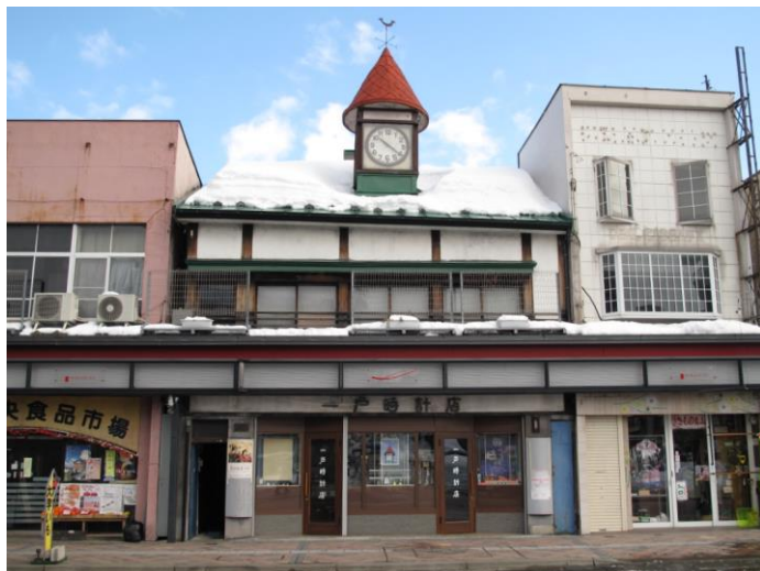
一戸時計店(明治32年頃建築)・土手町
