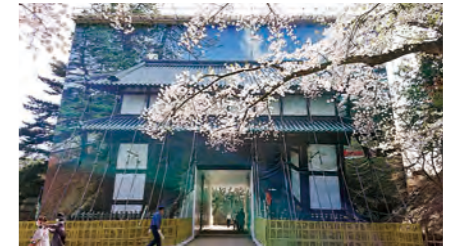
▲工事中の追手門と南内門の外観
