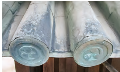
▲南内門窓底の銅瓦葺 (江戸時代中期のものと同定)
