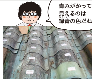
▲南内門2階屋根の南面に残る銅瓦葺 (江戸時代後期のものと推定)
