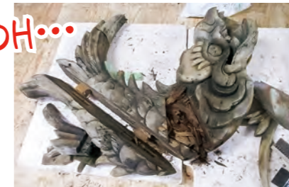
▲追手門・東側の鯨 木彫りの腐食状況
