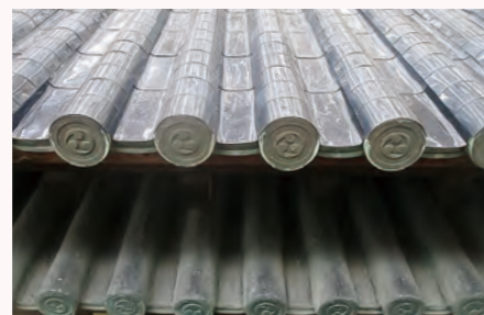
▲南内門2階屋根東面(上段は銅板葺替後、下段は今回修理しなかった窓底)
