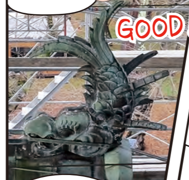
▲追手門・東側の鯨 木彫りの腐食状況
