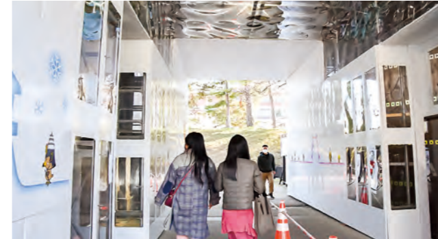
▲工事中の追手門通路。透明パネルで修理状況を見学できる。
