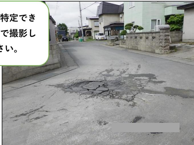
写真の例①：舗装の損傷（遠景）
