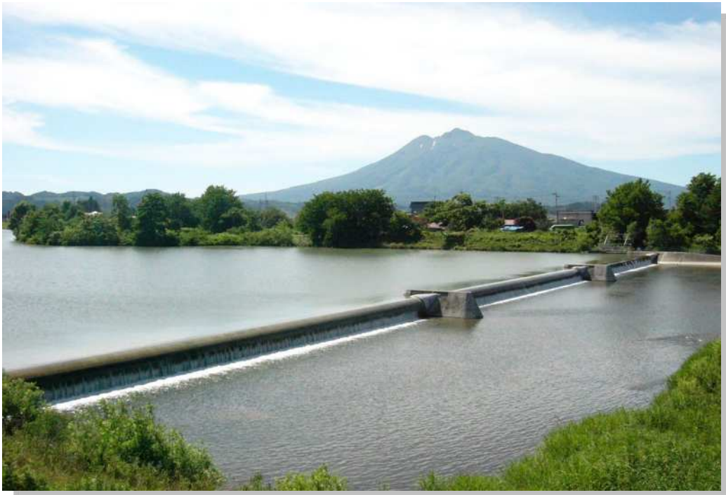
岩木川取水堰
