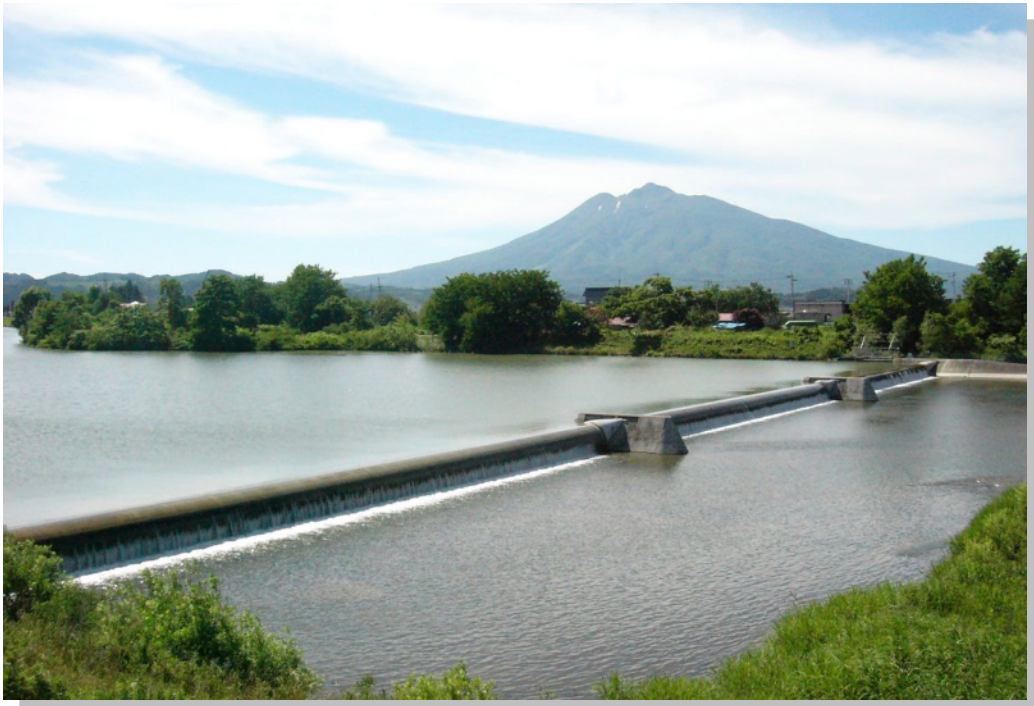
岩木川取水堰
