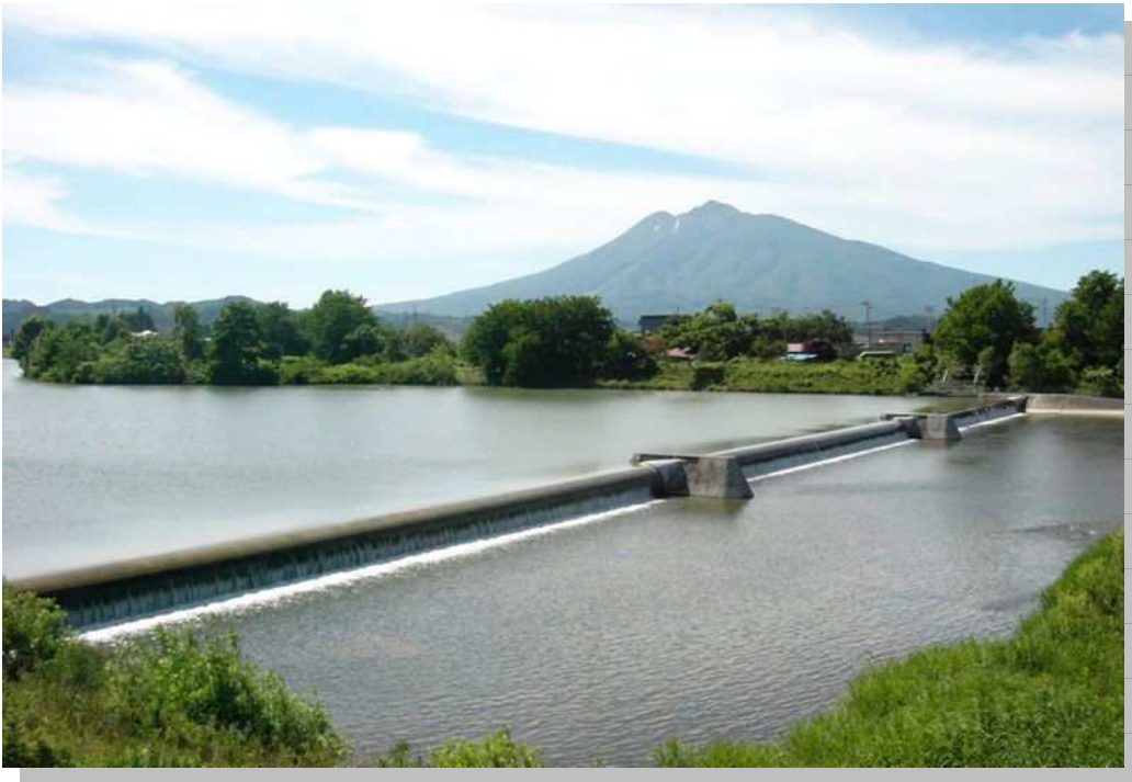
岩木川取水堰
