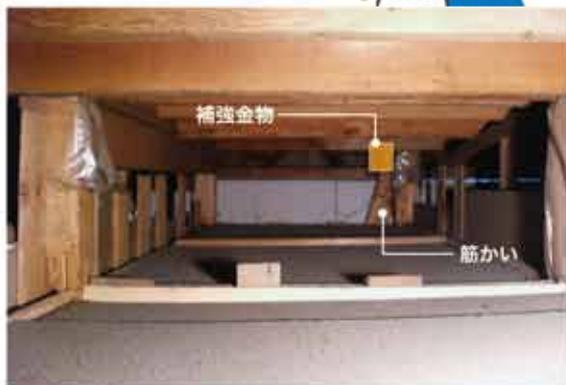
▲補強金物 2階床下:筋かいと柱・土台を補強金物で緊結
