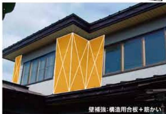
▲壁の補強 今ある壁を、筋かいと構造用合板による補強を行う。
