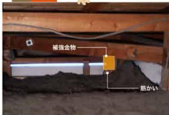
▲補強金物強 小屋裏:筋かいと柱・梁を補強金物で緊結
