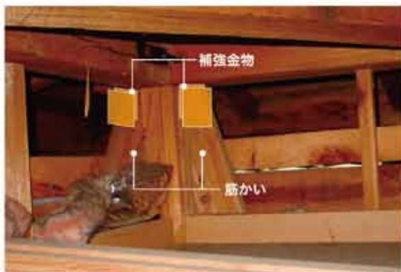
▲補強金物 筋かいと柱・梁・土台を補強金物で緊結
