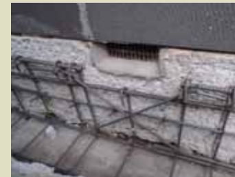
③ コンクリートで基礎を補強
