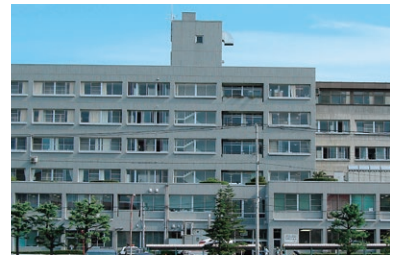
旧弘前市立病院 昭和46年(1971年)建築
