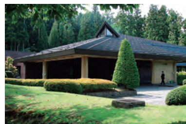
ひろ さき し さいじょう 弘前市斎場 昭和58年(1983年)建築
