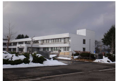
新築された校舎
