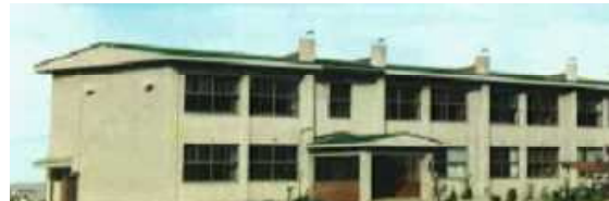
取り壊される予定の中学校旧校舎(昭和40年築)
