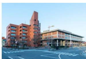
【弘前市庁舎 前川本館 昭和33年 前川新館 昭和47年竣工】
