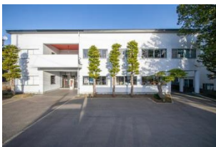
【木村産業研究所 昭和7年竣工】
