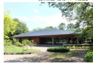
【弘前市緑の相談所 昭和55年竣工】
