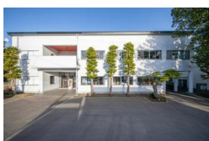
【木村産業研究所 昭和7年竣工】
