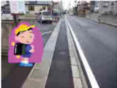
市道八幡宮線 北横町(改修後)
