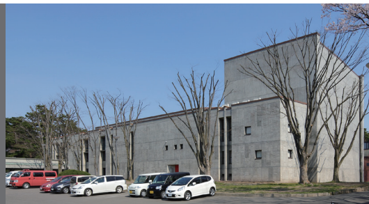
弘前市民会館外観
