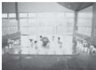
温泉源の掘削に成功、完成した御所温泉（昭和54年）
