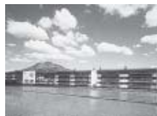
青森県初、ソーラーシステムの村営住宅
